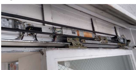
④自動ドア装置撤去
