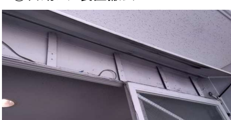
④自動ドア装置撤去
