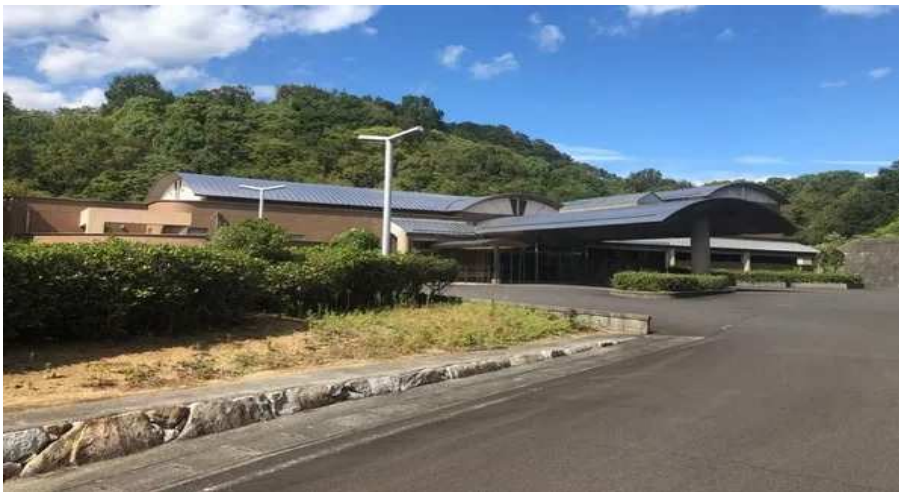
自動ドアフロント外観 （外観右側出入口：故障中張り紙有り）
