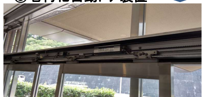
④ 自動ドア装置撤去
