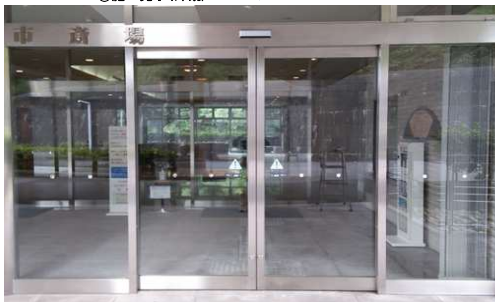
⑧ 施工完了(外観)
