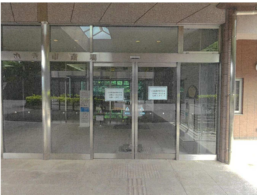
自動ドアフロント内観 SUSHL 自動ドアフロント内蔵両引き自動ドア装置
