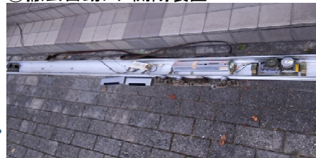
⑤ 撤去自動ドア開閉装置
