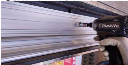
⑦ 新規自動ドア台板施工中
