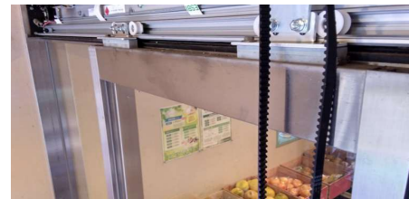
⑧ 新規自動ドア装置施工中
