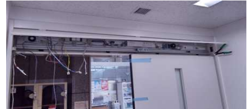
⑧ドア吊り込み調整中
