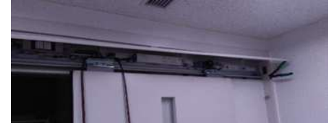
⑧ドア吊り込み調整中
