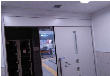
③老朽化自動ドア装置
