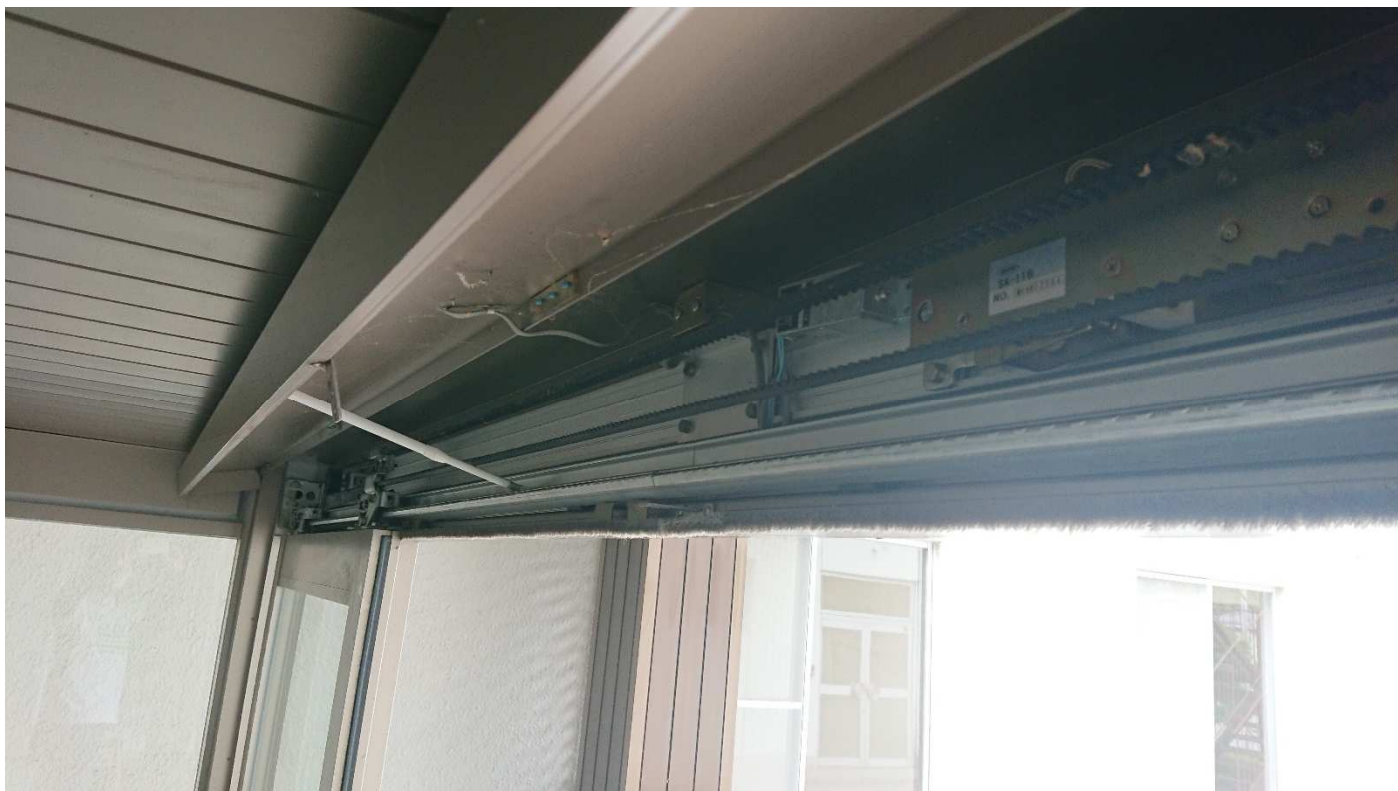
停電時施錠型オートロック装置
