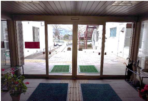
② 老朽化自動ドア装置取り外し
