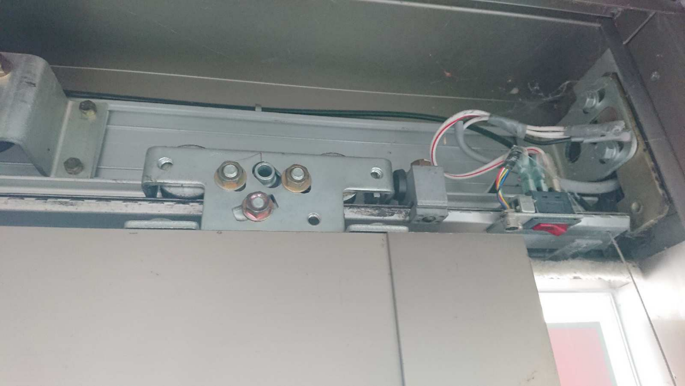
ロック解錠用ワイヤーの様子 / 内観右側コーナーピース取付の様子
