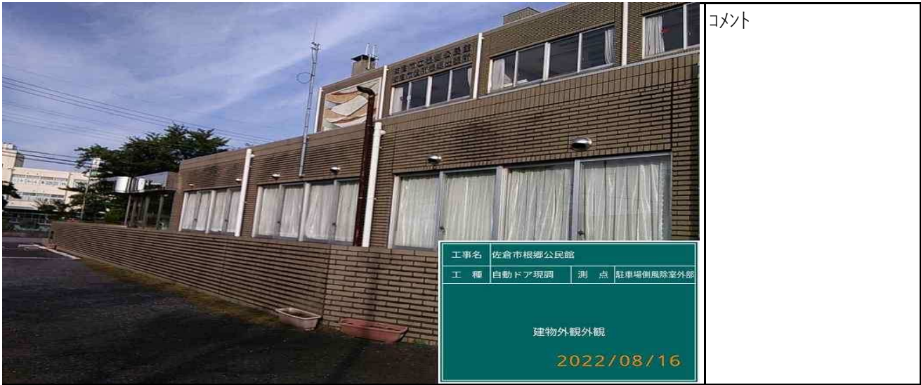
件名：佐倉市根郷公民館現場調査資料（写真） 建物外観
