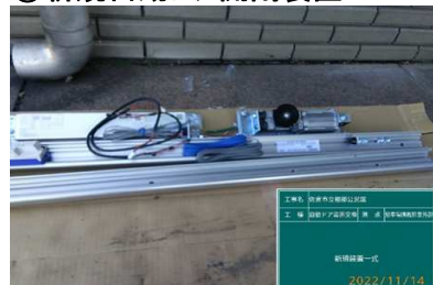
⑧新規自動ドア開閉装置の納り
