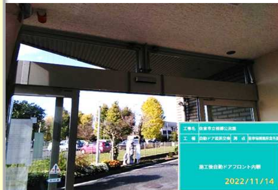
⑥新規自動ドア開閉装置
