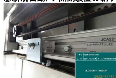
⑧新規自動ドア開閉装置の納り
