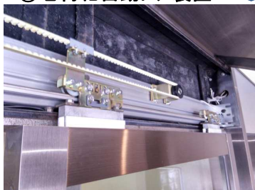
④老朽化自動ドア装置
