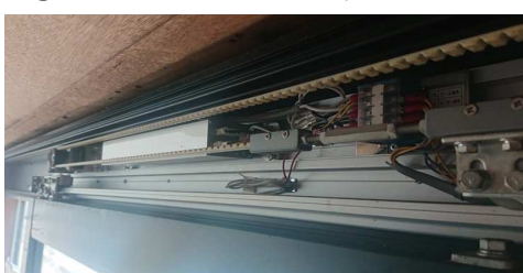
④自動ドア装置撤去
