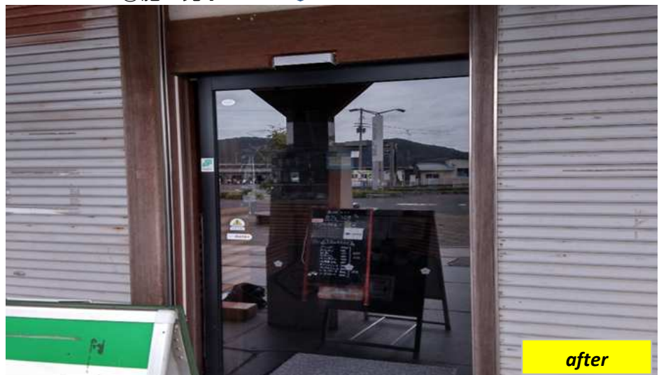
⑧施工完了
