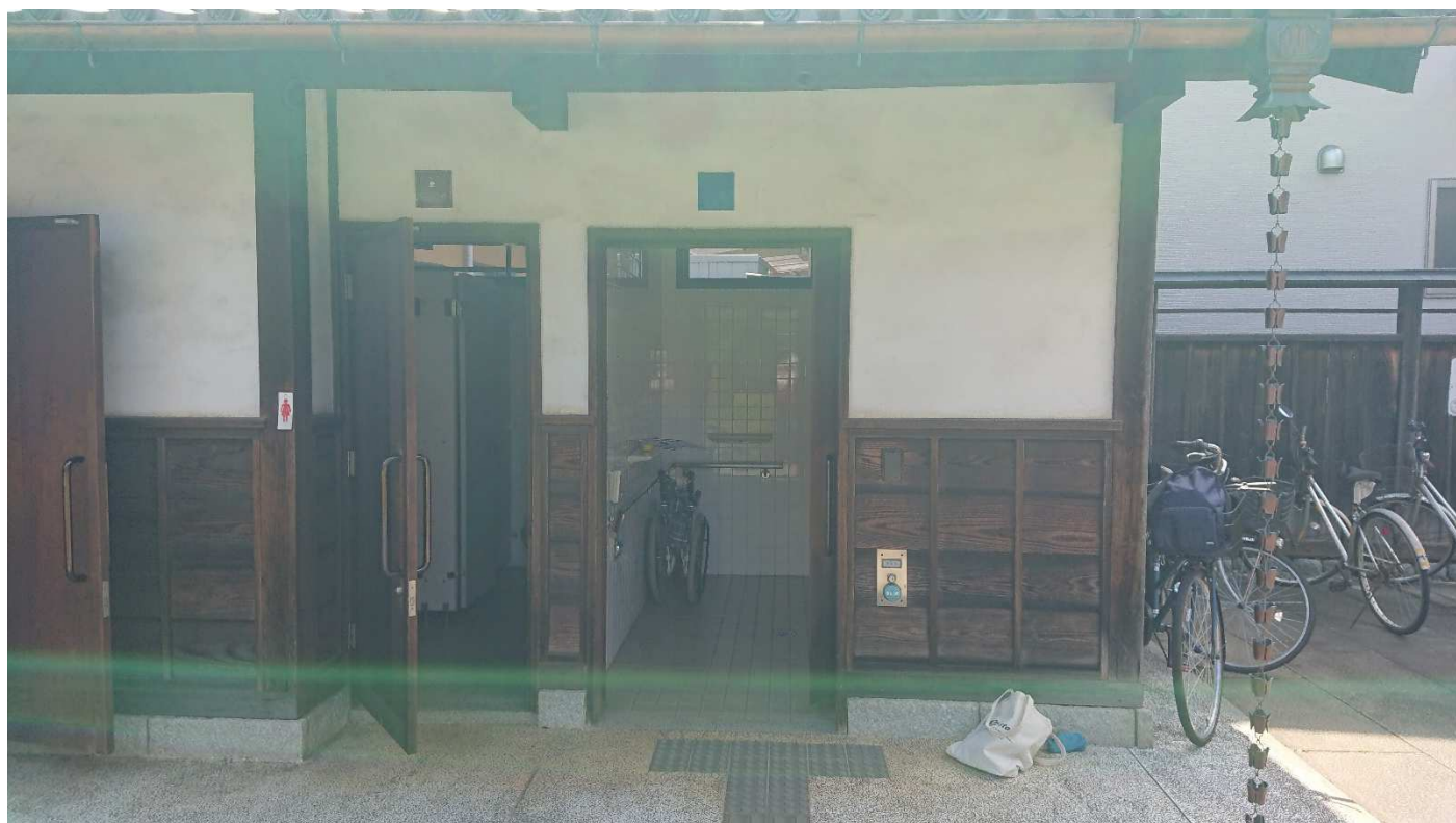
ふじみ野市立福岡河岸資料館 多機能トイレ外側より撮影
