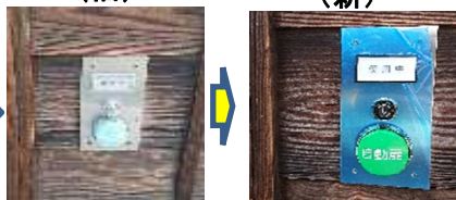
⑧ 新規自動ドア開閉装置
