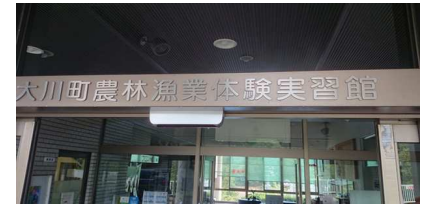
⑧ 新規自動ドア装置交換後外観
