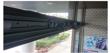
⑥ 新規自動ドア開閉装置
