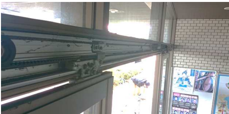
③ 老朽化自動ドア開閉装置撤去
