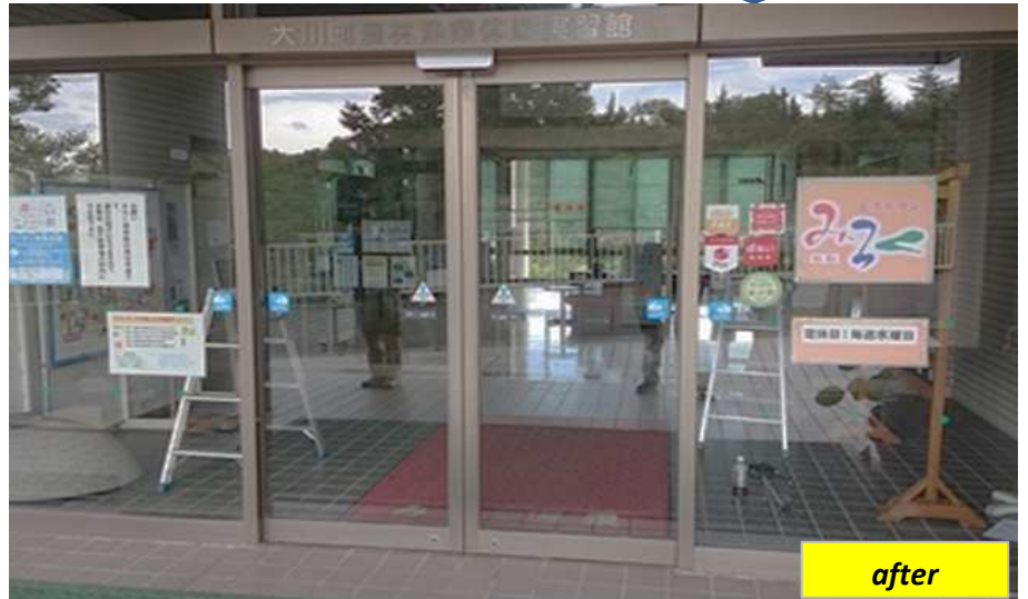
⑤ 自動ドア装置交換工事完了
