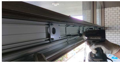
⑤ 新規自動ドア開閉装置台板
