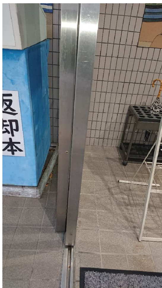
補助光線センサ（対向式1光線）
