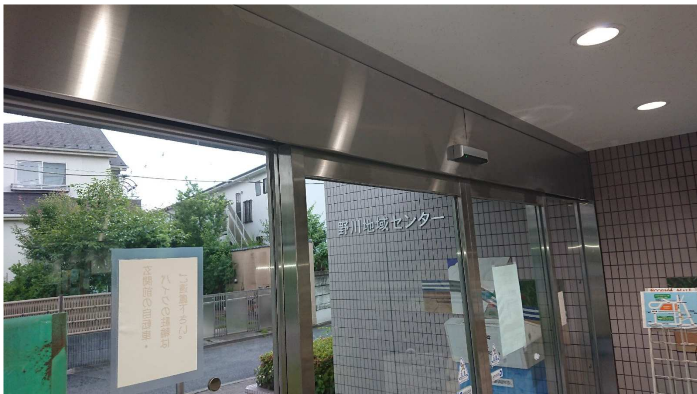
補助光線センサ（対向式1光線）
