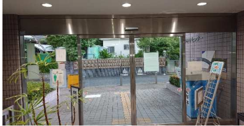
②施工前(老朽化開閉装置)
