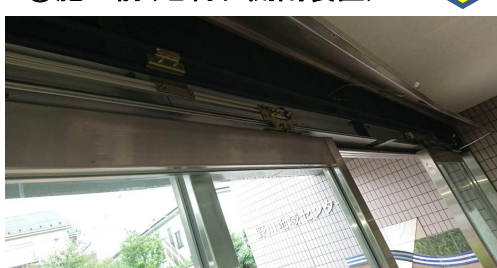
③施工前(老朽化開閉装置)
