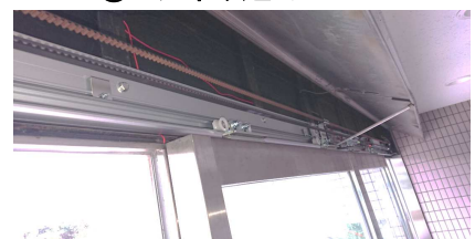
⑧ドア吊り込み
