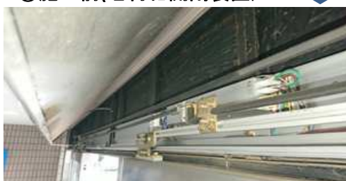
④老朽化開閉装置撤去
