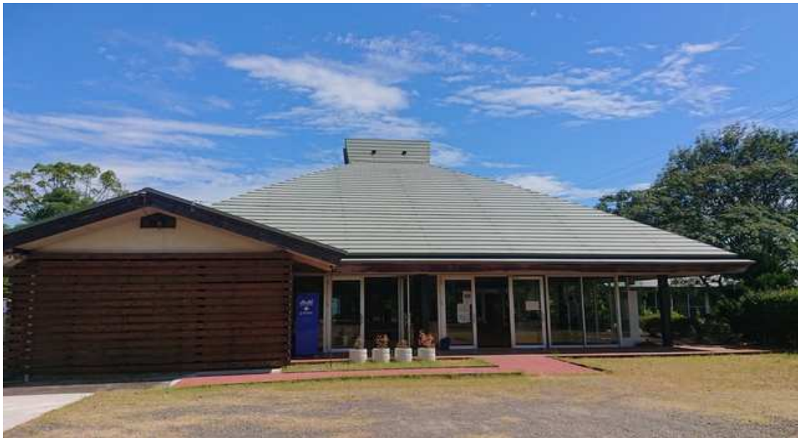
自動ドアへ変更箇所外観
