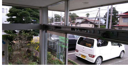
⑤自動ドア装置取付中
