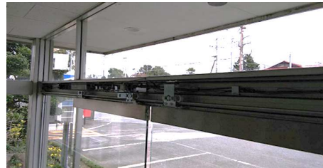
⑦新規自動ドア開閉装置交換完了
