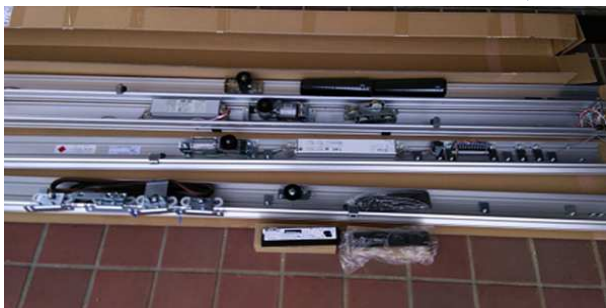
③ 施工中(自動ドア開閉装置撤去)
