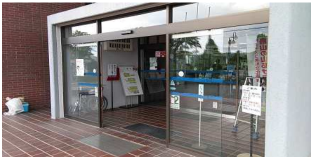
② 施工中(老朽化自動ドア開閉装置)
