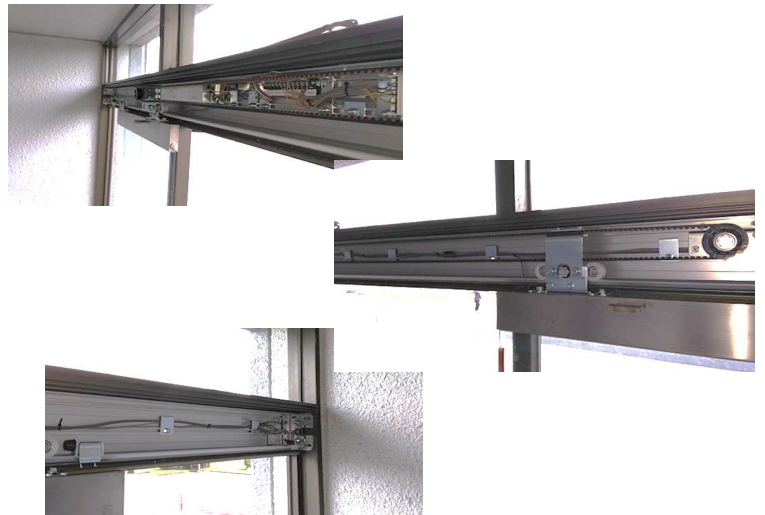
⑤ 自動ドア装置交換工事完了
