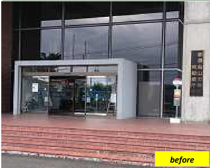
① 施工前(老朽化自動ドア装置)
