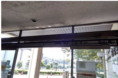
③ 老朽化装置撤去後
