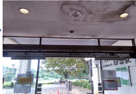
⑤ 新規自動ドア装置設置
