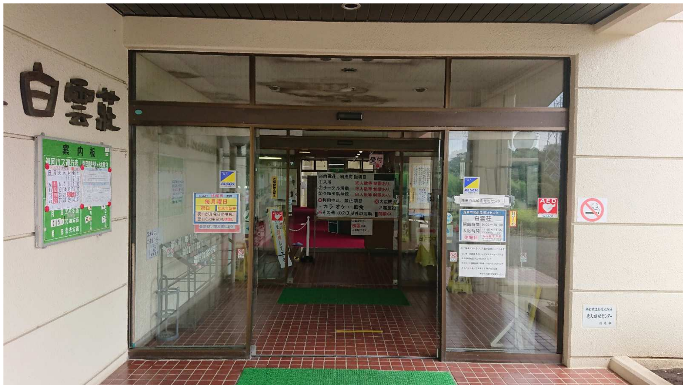
風除室外側自動ドア装置 建物外側より撮影
