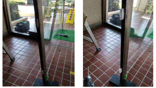
⑥ 振れ止め交換作業
