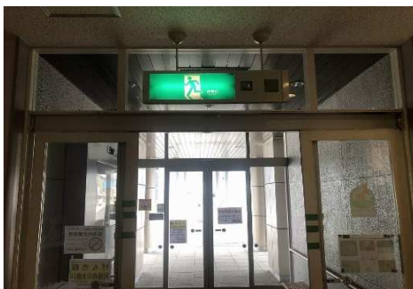
③ 老朽化自動ドア開閉装置撤去
