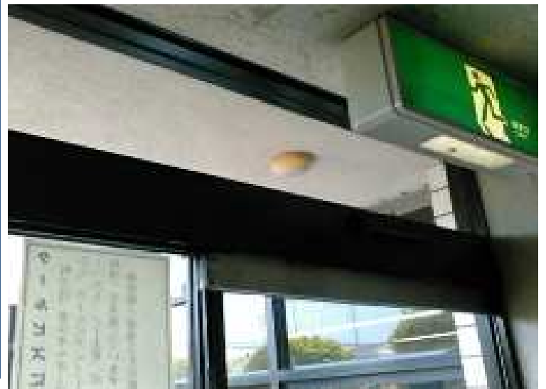
⑤ 自動ドア装置交換工事完了
