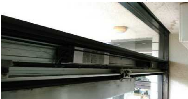
③ 施工中(自動ドア開閉装置撤去)
