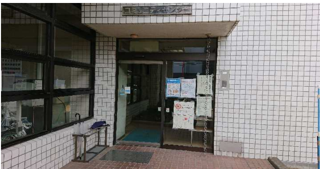
② 施工中(老朽化自動ドア開閉装置)
