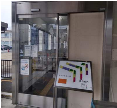
②老朽化自動ドア装置
