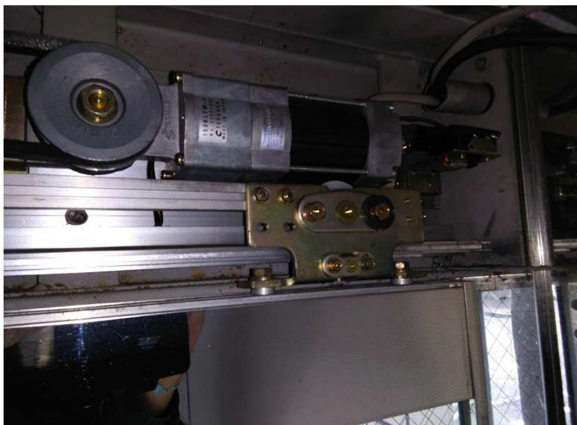
自動ドア開閉装置 駆動部
