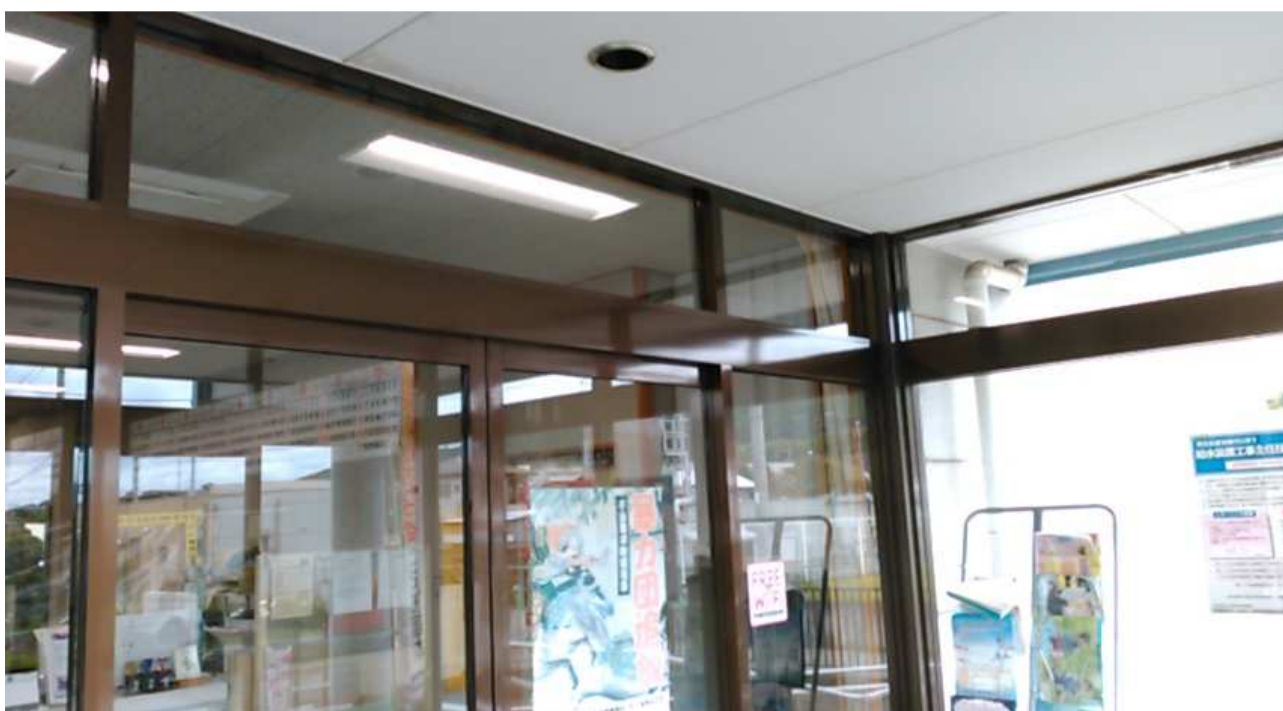
自動ドアフロント外観
