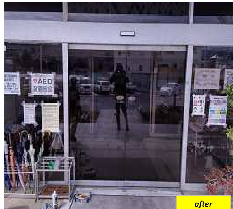
⑧ 設置完了
