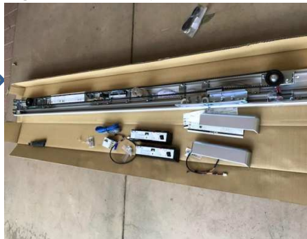
⑥ 自動ドア装置交換工事完了
