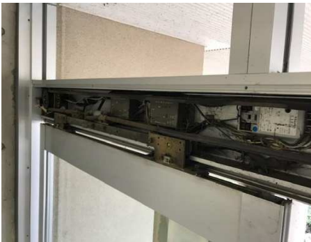
② 施工中(自動ドア装置撤去)
