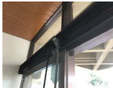
④ 施工中(旧自動ドア開閉装置)
