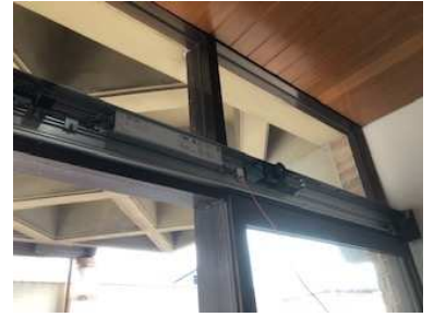
⑤ 施工中(新自動ドア開閉装置)
