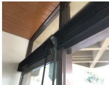
④ 施工中(旧自動ドア開閉装置)
