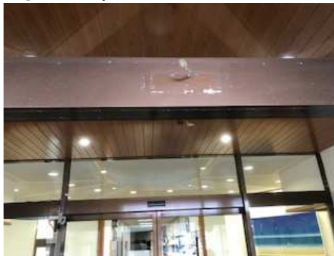
③ 施工中(センサー撤去)
