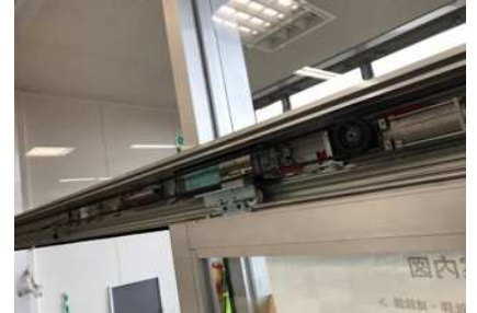
⑤ 施工中(新自動ドア開閉装置)
