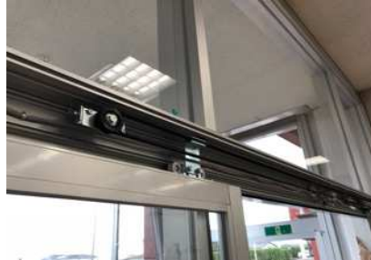
④ 施工中(新自動ドア開閉装置)
