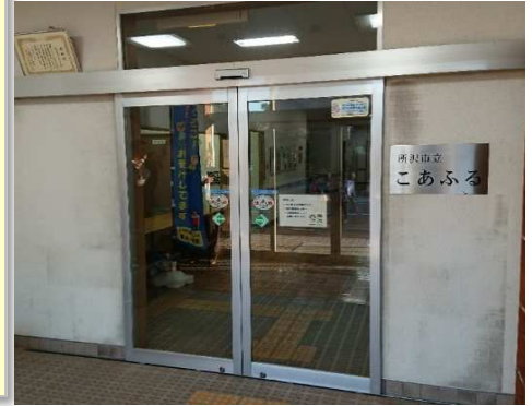
④ 施工中：老朽劣化自動ドア開閉装置撤去
