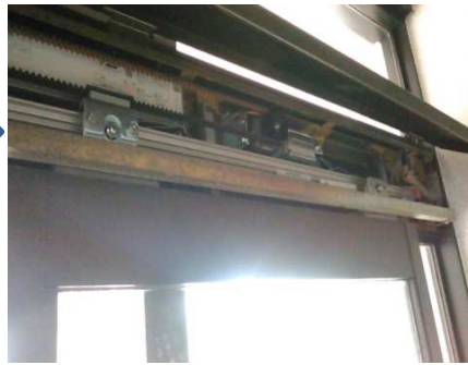
⑥ 自動ドア装置交換工事完了
