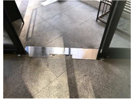
⑤ 施工中(フロアヒンジ補修)
