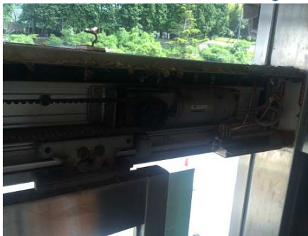
③ 老朽化自動ドア装置
