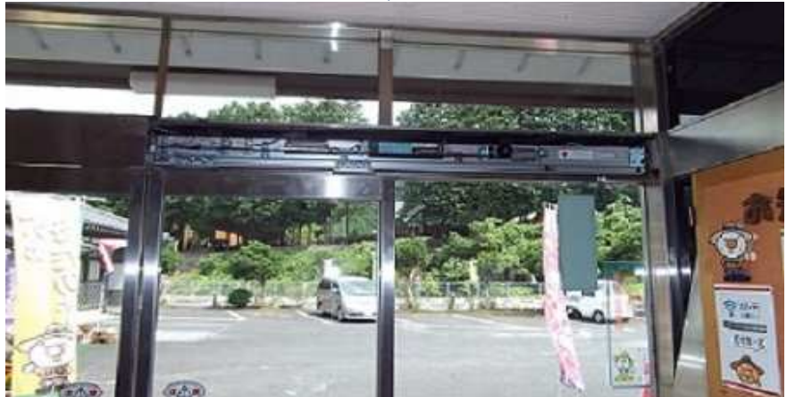
⑦ 自動ドア装置交換工事完了
