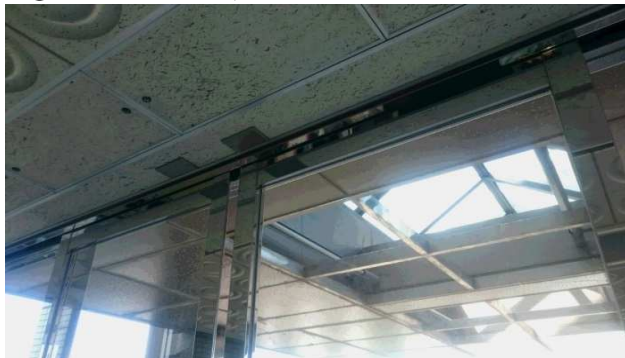
③ 施工中(老朽劣化自動ドア装置)
