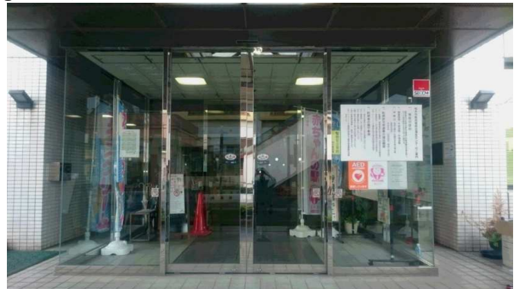
⑧ 施工完了
