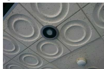
⑥ 施工中(旧センサ)
