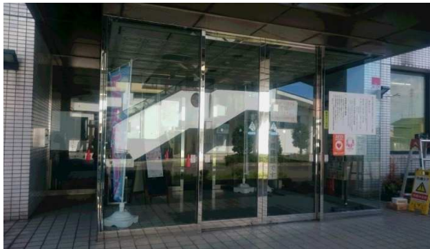
② 施工中(天井裏納まり)
