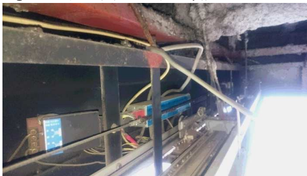
③ 施工中(老朽劣化自動ドア装置)
