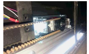
⑤ 施工中(駆動部)
