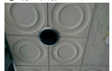
⑦ 施工中(新センサ)
