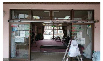
⑧ 新規装置取付工事中
