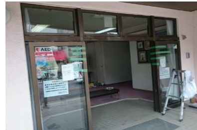
⑤ 老朽化装置撤去
