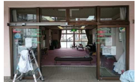
⑥ 新規装置取付工事中
