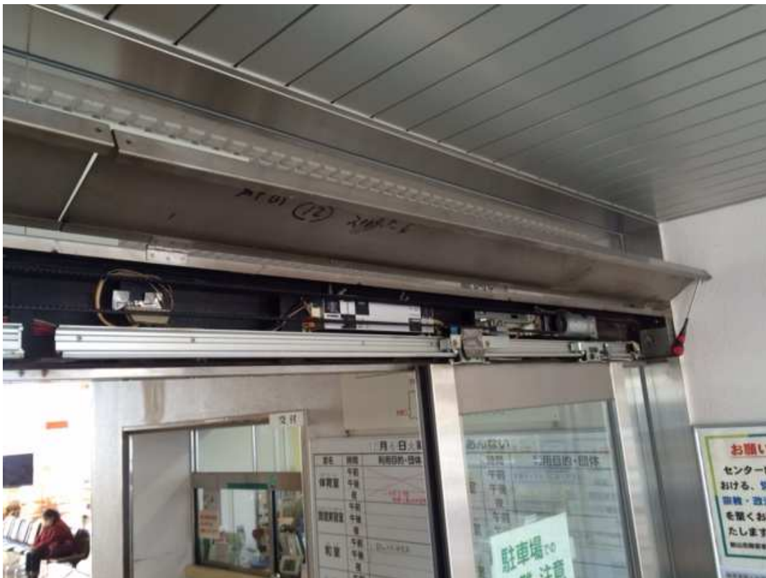
風除室内側自動ドア装置 内部の様子
