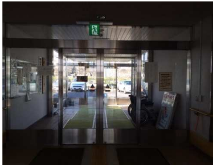
② 施工中(撤去前)
