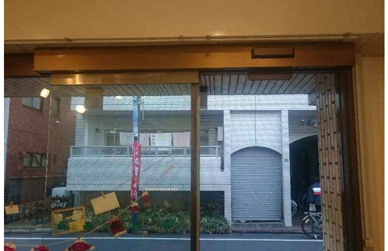
⑧ 設置完了
