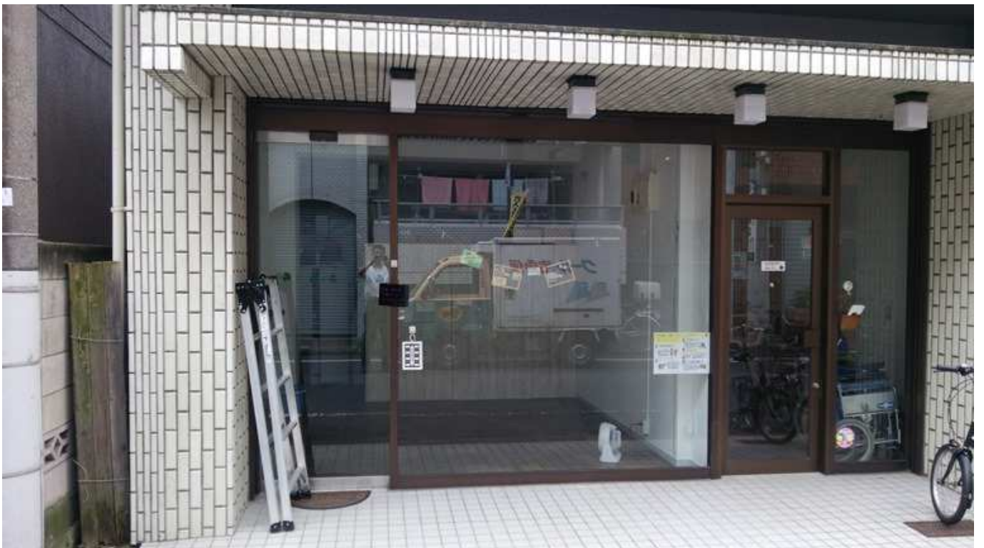
外側から全体写真
