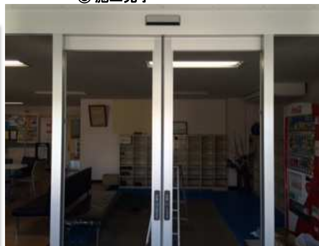
⑧ 施工完了
