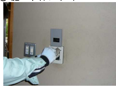
⑦ 施工中(振れ止め取付)
