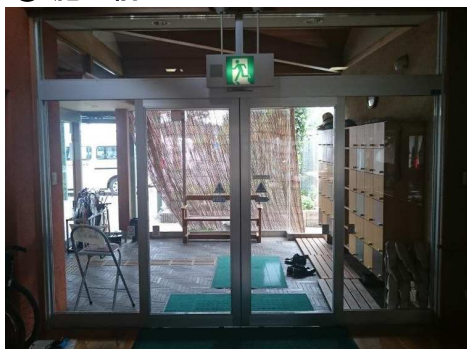
② 施工中(老朽化装置撤去)
