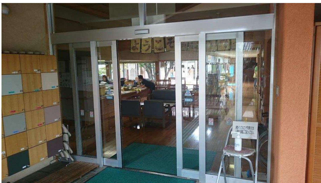
風除室 内側自動ドア 外観
