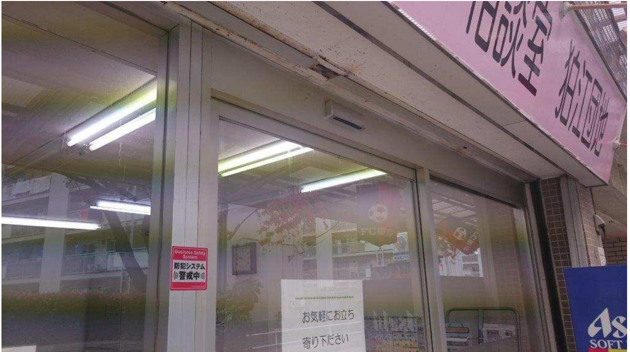
外側センサの様子 (シャッターとの隙間 40mm)
