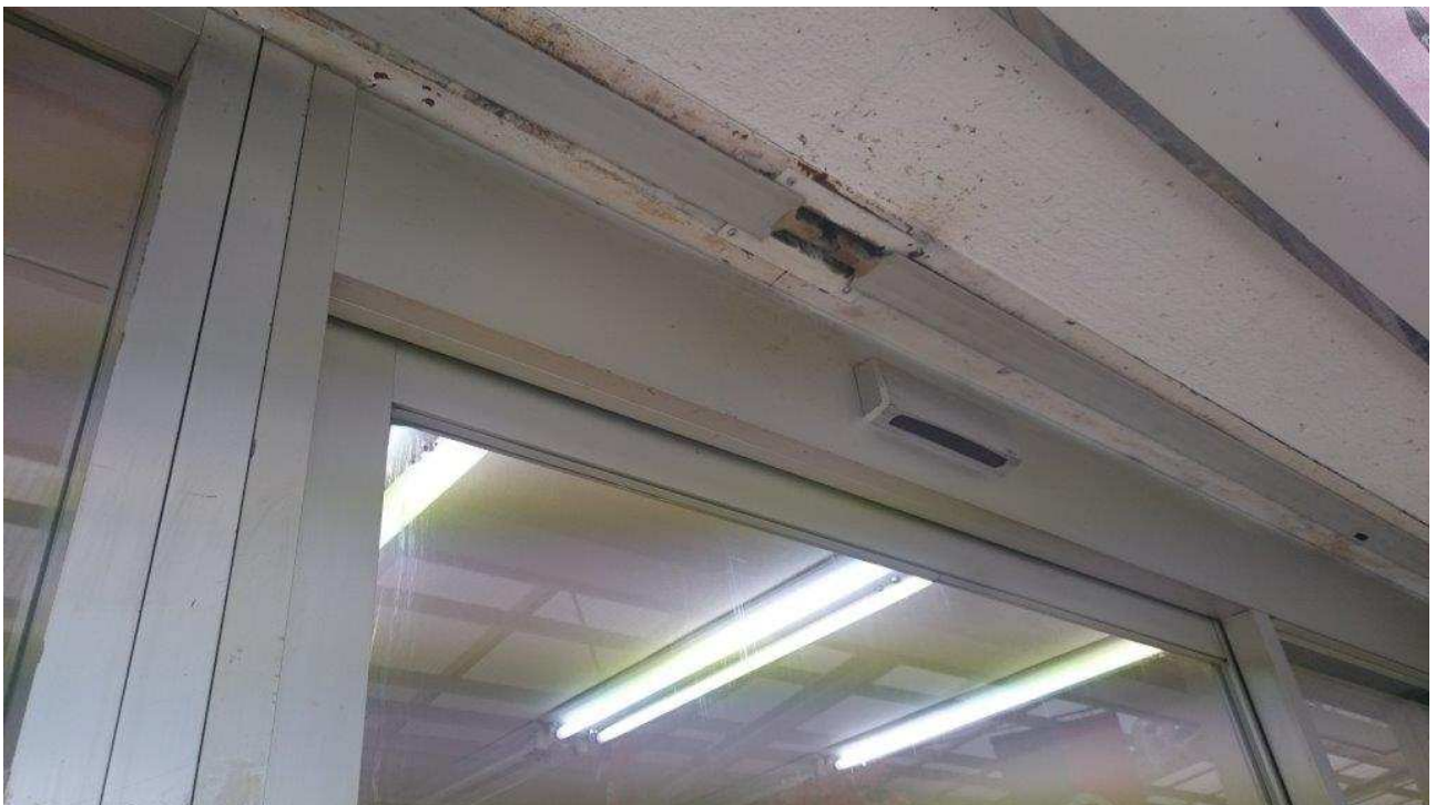
外側センサの様子 (シャッターとの隙間 40mm)
