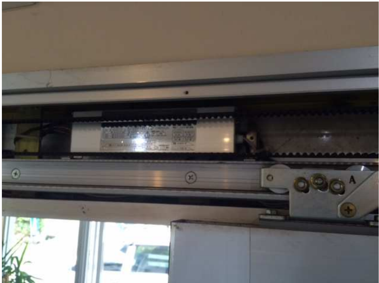
老朽化エンジン内部の様子(制御部)
