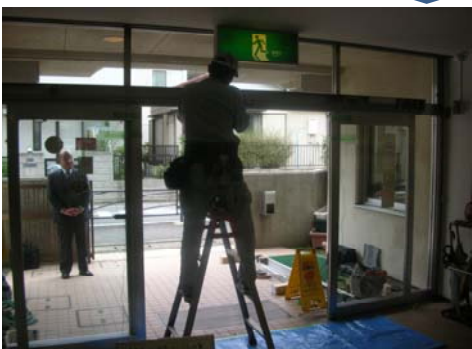
③ 老朽化自動ドア装置撤去
